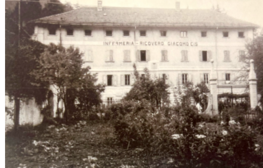
1975, Lato sud della Casa di Riposo prima della ristrutturazione
